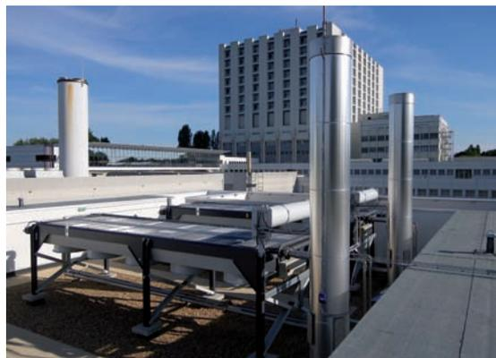
L'opération a été menée dans sa globalité : **SDMO**® a réalisé les études de génie civil, suivi toute la réalisation et livré la centrale clef en main. La partie contrôle-commande de la nouvelle centrale est assurée par des armoires Kerys. Trois coffrets Kerys permettent par ailleurs de vérifier le bon fonctionnement de l'ancienne centrale, voire de la démarrer.
