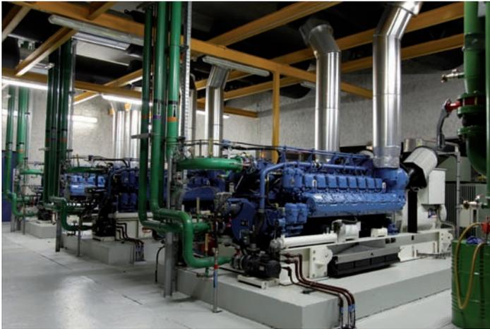
Le CHU de Rennes est doté d'un système de sécurité exemplaire. Quatre groupes **SDMO**® sont couplés au réseau en HT et garantissent une parfaite autonomie et une sécurité optimale.
