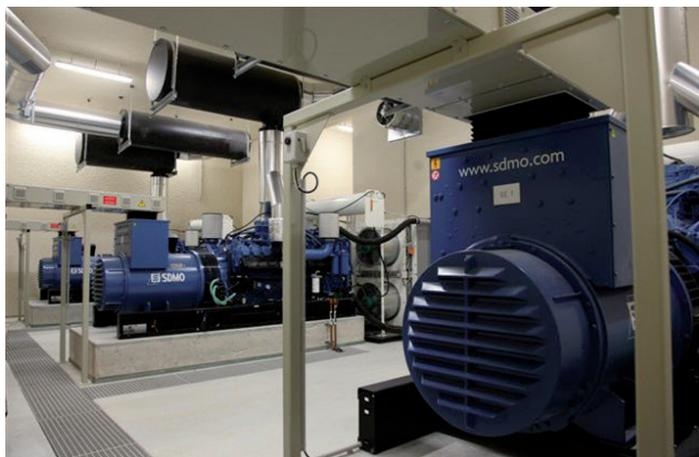
Témoignage du savoir-faire et de l'expérience de **SDMO**® dans le secteur de la santé, la centrale électrique équipant le nouveau Pôle Santé d'Olonne-sur-Mer (85) est remarquable : outre une qualité de finition irréprochable, cette centrale, composée de 3 groupes électrogènes de 1.000 kVA est installée en couplage réseau BT pour garantir une sécurité optimale du site.
