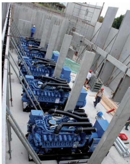
Le Centre Hospitalier Jean Minjoz de Besançon (25) dispose de deux groupes électrogènes de sécurité équipés d'un coffret d'inhibition des sécurités, ainsi que de cinq groupes électrogènes de 2.200 kVA. Ces groupes sont équipés de moteurs MTU 16V4000 et pilotés par une armoire de contrôle commande Kerys.
